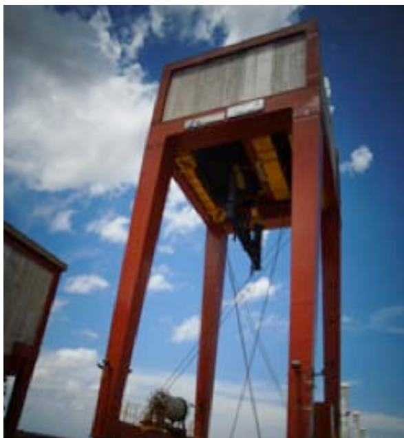
Recuperação de um pórtico da elevação 225.
