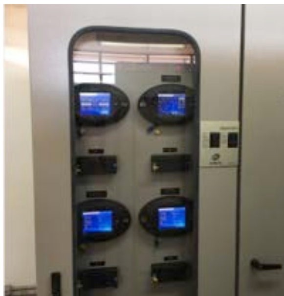
Painel de Medição de Faturamento.
