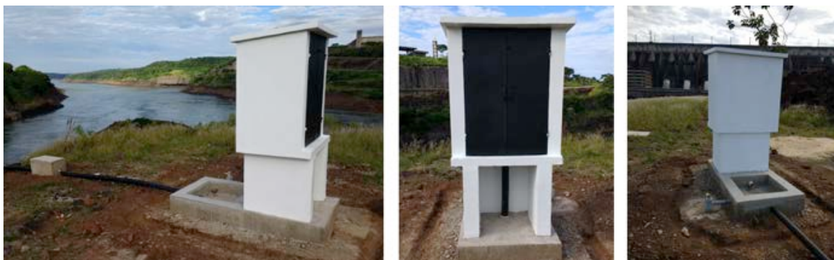
Construção do abrigo para instalação dos equipamentos.
